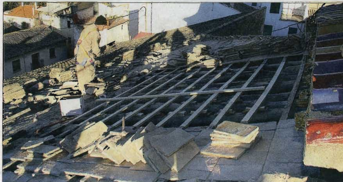
Treballs d'obra per a eliminar la humitat
